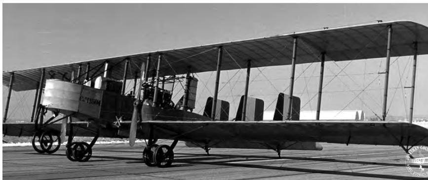
Aereo "Caproni" utilizzato nella prima guerra mondiale. Le ali, della lunghezza di 12 metri, erano costituite da un'intelaiatura in legno rivestita in tela. Il legno, per le sue caratteristiche di resistenza meccanica, flessibilità, e leggerezza, era ritenuto il materiale più idoneo per la costruzione dei primi aeroplani. Una struttura di grande dimensione che doveva essere leggera ma resistente alle forti sollecitazioni.
