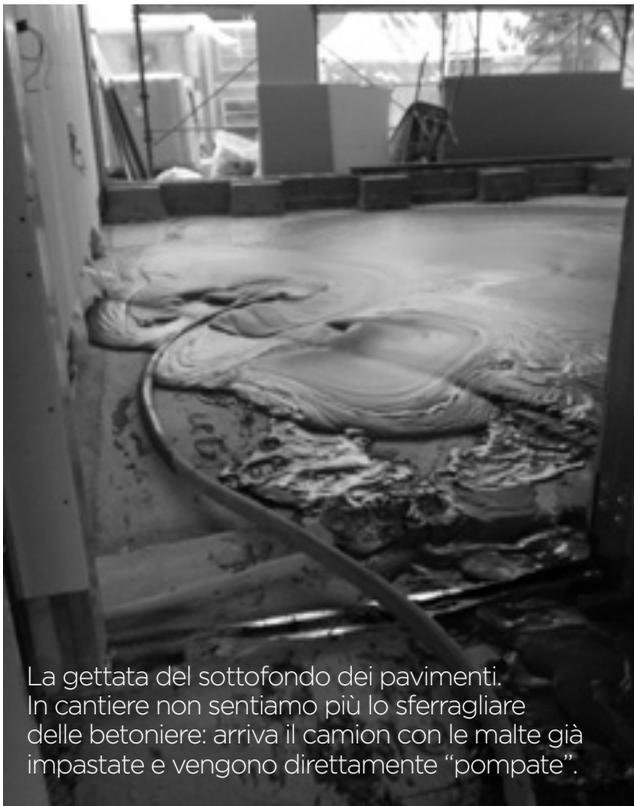
La gettata del sottofondo dei pavimenti. In cantiere non sentiamo più lo sferragliare delle betoniere: arriva il camion con le malte già impastate e vengono direttamente "pompe".
